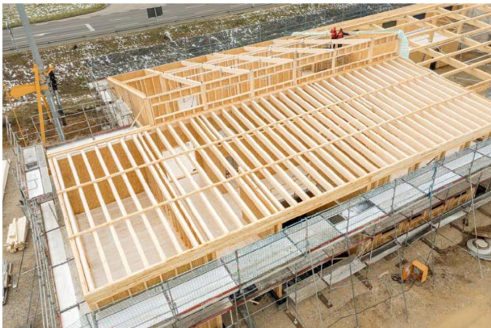
▲ 51 m³ BSH: Die Dachkonstruktion wurde als weit gespannte BSH-Tragstruktur ausgeführt
